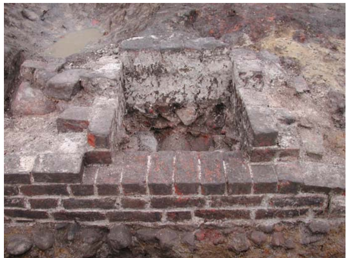
Den murede niche i kælderns vestmur. Nichen er kalket indvendigt og i midten anes de store fundamentssten. Måske er det bunden af en latrinskakt, som har fortsat i de øvre stokværker.
