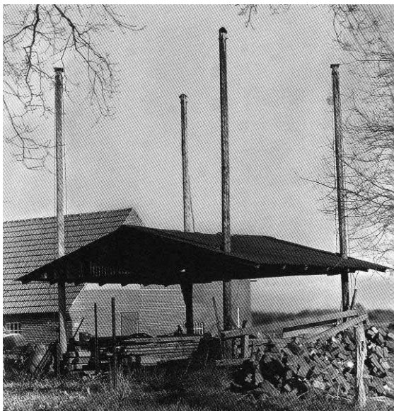
Figur 5. Eksempel på en staklade fra nyere tid. Fire stolper sat i et kvadrat og med et tag, hvis højde kan reguleres op og ned af stolperne, afhængigt af mængden af afgrøder. Efter Zimmermann 1991.
