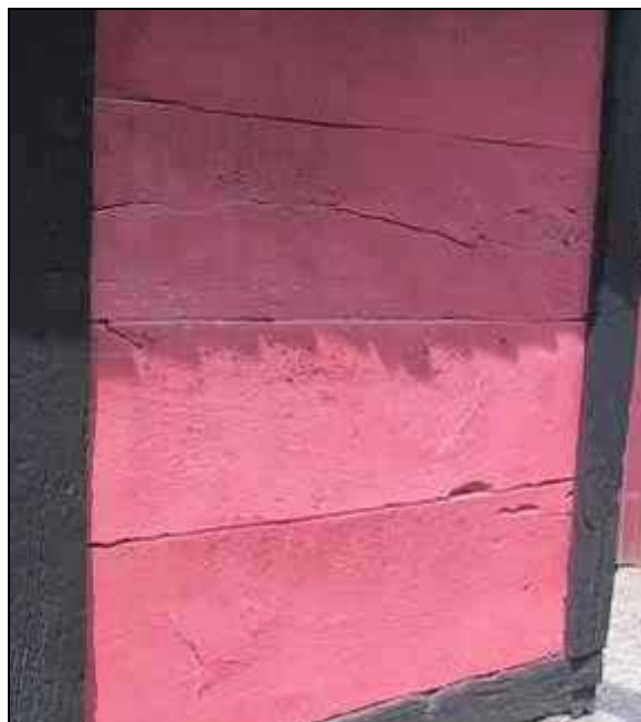
Figur 10: Nyere eksempel på rødmalet bulvæg. Der kan også have været bemaling på bygninger i jernalderen.
