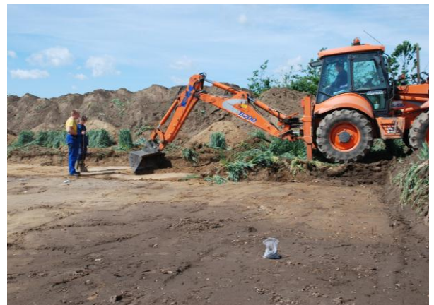
Muldafrømning med rendegraver
