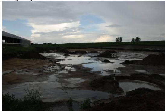
Vandet viste tydeligt hvor brøndene var.
