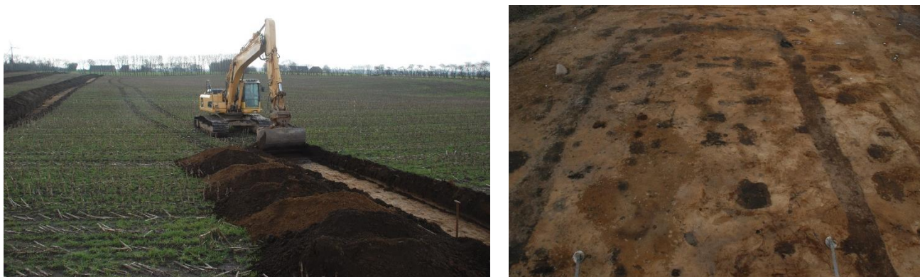
Figur 4. En gravemaskine i færd en med forundersøgelse i 2014. Foto: Viborg Museum. Foto til højre: stolpehuller og væggrøfter aftegner sig som mørkebrune pletter mod den gule undergrund i søgegrøft. Fra en udgravning i 2014. Foto: Viborg Museum.
